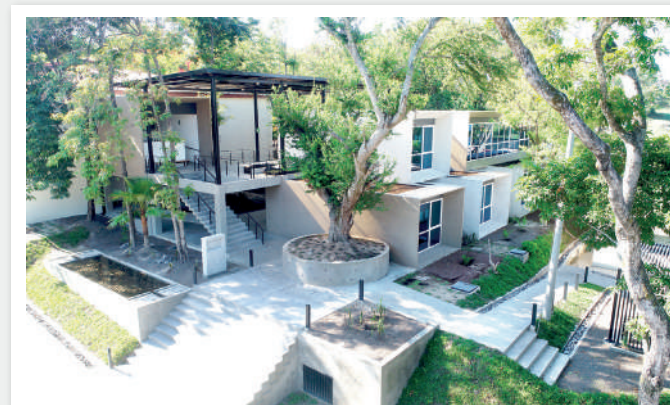
Edificio Anexo de la Facultad de Ciencias de la Rehabilitación
